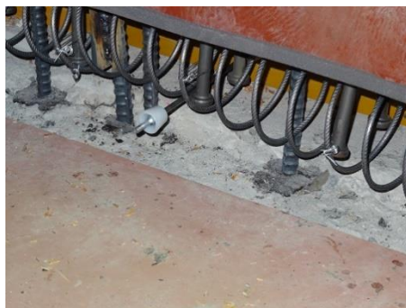
中学校枠付き鉄骨ブレース
