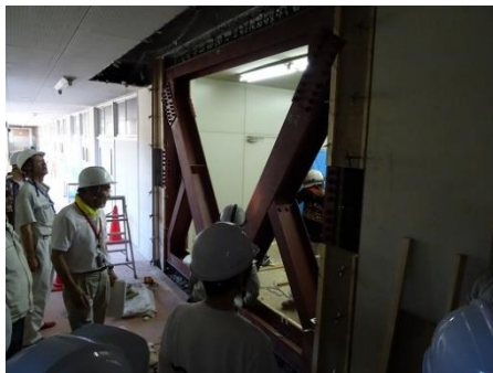
中学校枠付き鉄骨ブレース
